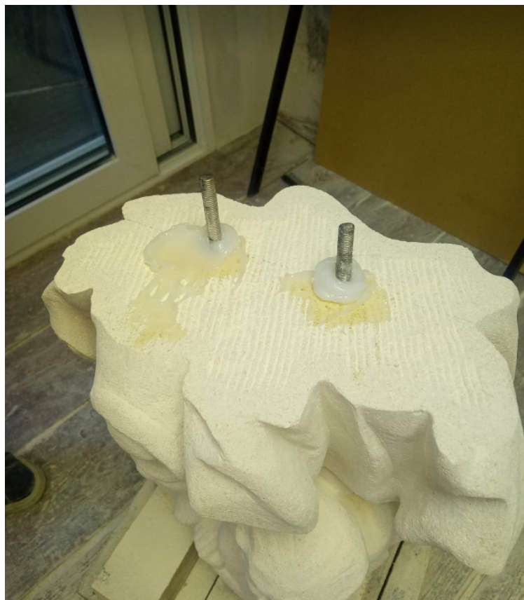
Slika 56. Prikaz apliciranja ankeri netom prije spajanja elemenata. Snimio K. Budiselić, 2022.
