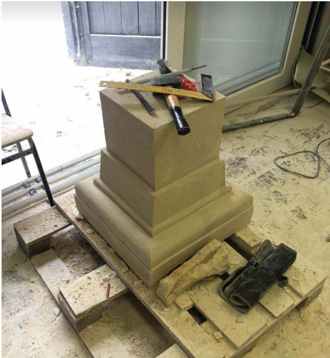
Slika 53. Prikaz postolja nakon dovršetka obrade. Snimio D. Pekić, 2022.
